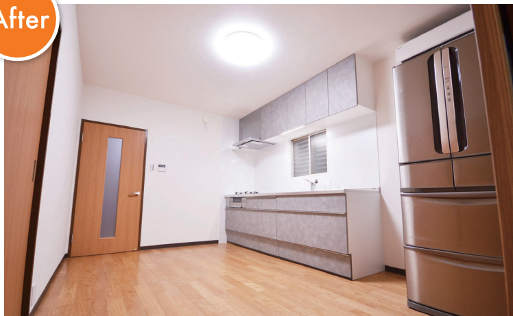
▲ I型キッチンにし、勝手口を塞いで部屋がスッキリ広々。安全性を考慮し、コンロ前の窓も塞いだ
